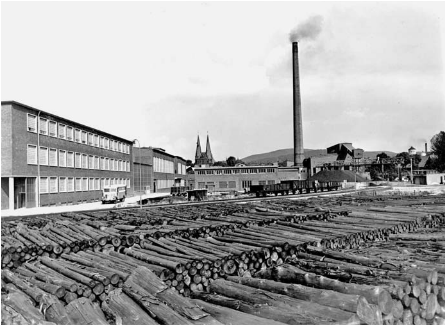
Holzplatz der Hannoverschen Papierfabriken auf dem Werksgelände in Alfeld/Leine 1956. Auf dem Platz lagert der Holzvorrat der Zellstofffabrik für vier Wochen – bei einer Monatsproduktion von etwa 1.800 t Sulfitzellstoff. Foto Hannover Papier, Alfeld.
