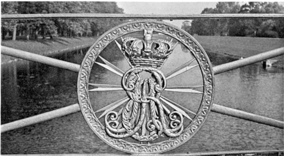
Abb. 10. Detail der Friederikenbrücke am Herrenhäuser Garten
