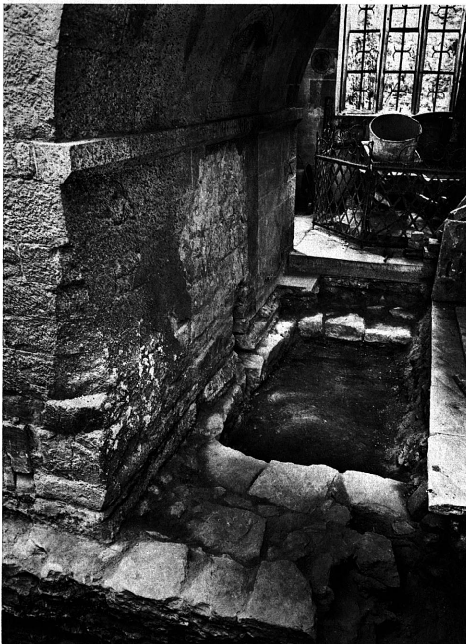
10. Hildesheim, Hl. Kreuzkirche P. II. - Westbaufundamente, Südliche Quertonne
