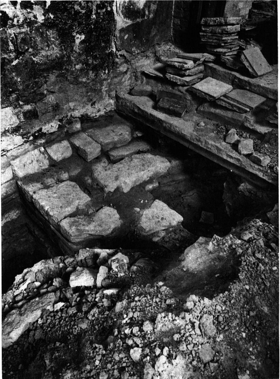
11. Hildesheim, Hl. Kreuzkirche Fundament der P. III. - Hochchorapside
