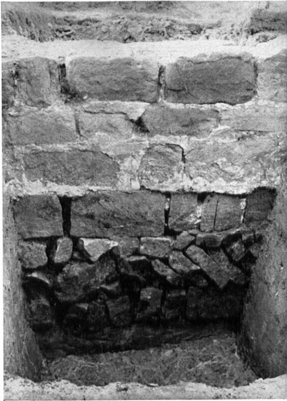
a) Teil der südlichen Kirchenmauer
