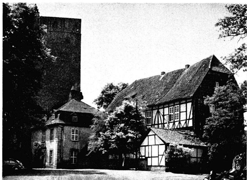
19. Schloß Adelebsen, Hof der Oberburg mit Rentei (1749), Forstamt (1685) und Brunnenstube.
