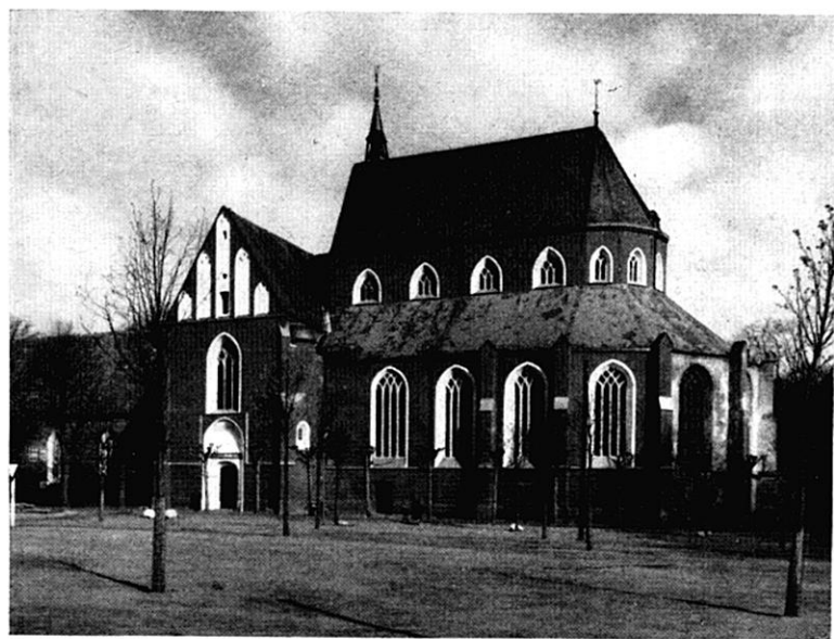
32. Norden, Ludgerikirche, nach den Instandsetzungsarbeiten 1956.
