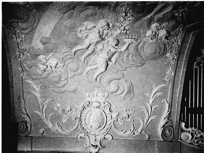
29. Clemenswerth, Schloßkapelle, von Joh. Konrad Schlaun 1741 erb., Stuckdecke nach der Restaurierung 1957.
