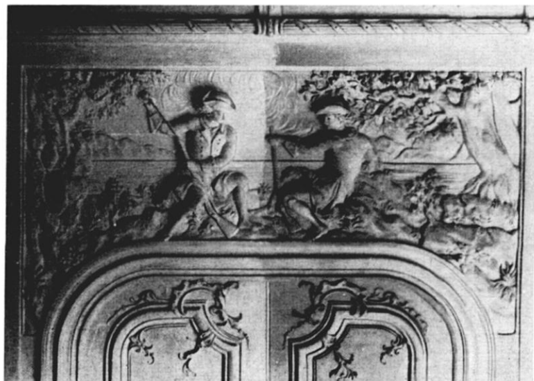
27. Schloß Clemenswerth, Stuckfeld über der Tür während der Reinigungsarbeiten
