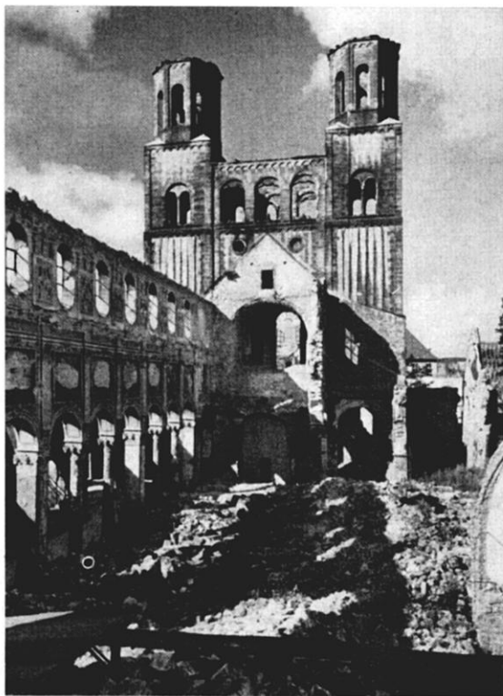
20. Hildesheim, Dom nach der Zerstörung
