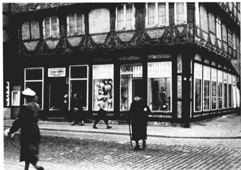
2. Celle, Hoppenerhaus. Schaufenster
